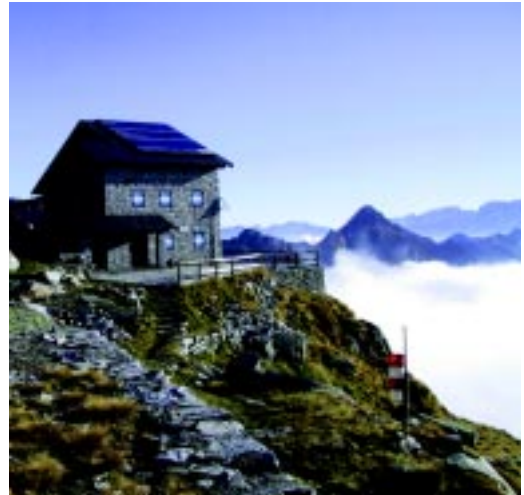
Il rifugio Carè Alto sul cui tetto è ben visibile l'impianto fotovoltaico
