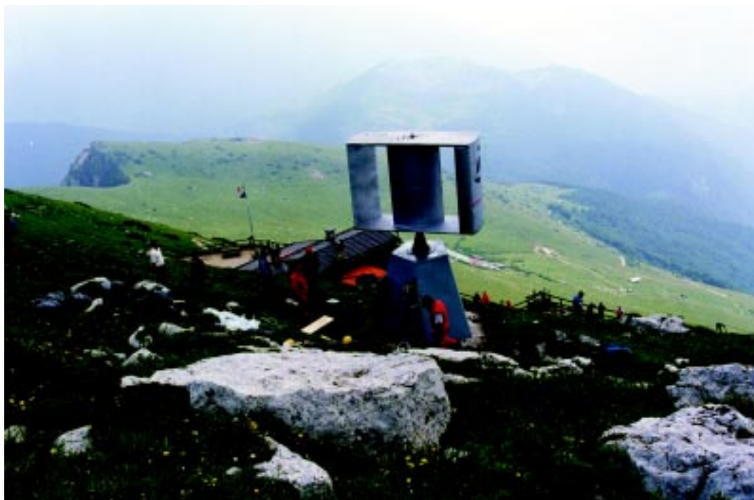
L'impianto eolico durante la fase d'installazione presso il Rifugio Marchetti allo Stivo
